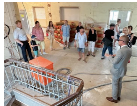
Baustellenbesichtigung in exponierter Lage in Erfurt
